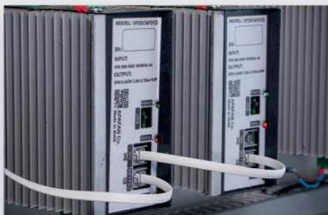
داریو اختصاصی به ازای هر پوزیشن با قابلیت اتصال به اینترنت special motor driver for each motor
