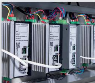
درایو اختصاصی به ازای هر پوزیشن با قابلیت اتصال به اینترنت special motor driver for each motor
